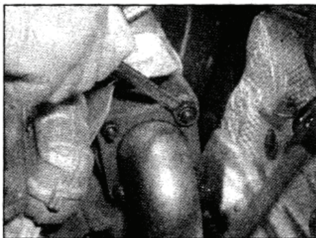
16.7a Открутите гайки и отсоедините распределительную трубу от выхода турбогенератора
