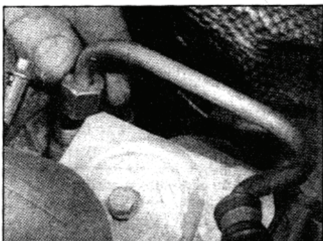
16.6b Разъединение трубы подачи масла на турбогенераторе
